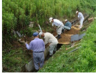
農用地法面の初期補修
