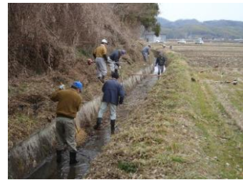
水路の草刈り及び泥上げ
