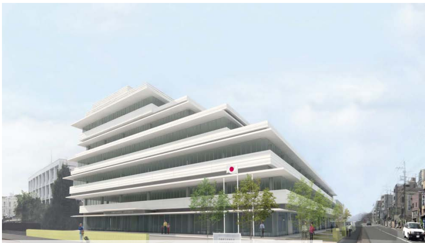
京都府警察本部新庁舎（工事中） 令和元年度末竣工予定
