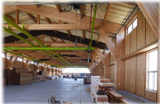
CLTを利用した工場建物
