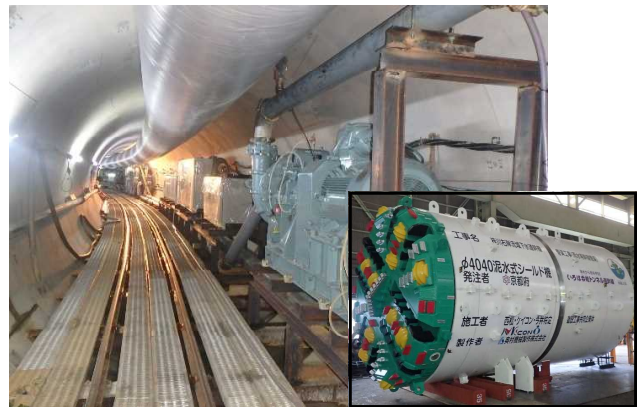
南幹線シールドトンネル掘進状況
