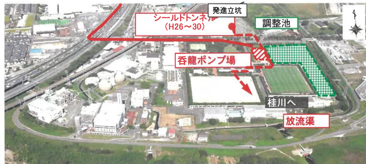
○洛西浄化センター（いろは呑龍トンネルの雨水処理）全景
