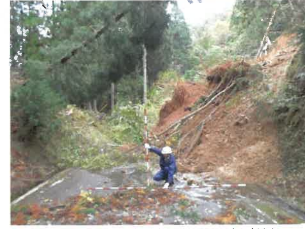
【場所】綾部市睦寄町大岩 (主) 舞鶴和知線 【被災状況】法面崩壊 延長60m 【復旧内容】法面工 150,000千円
