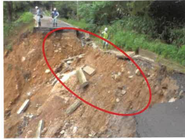
【場所】京丹後市・伊根町 (一) 久僧伊根線 【被災状況】車道欠壊 延長234m (7箇所7工区) 【復旧内容】擁壁工・盛土 204,000千円
