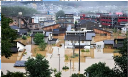
弘法川 溢水状況
