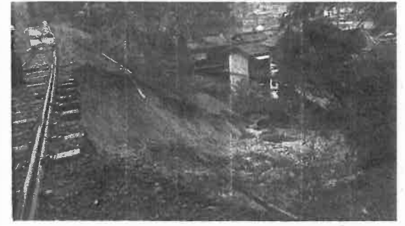
台風21号による被災状況（平成29年10月22日）
