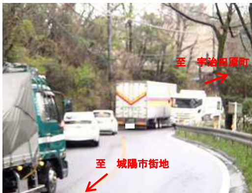
【写真-1 線形不良の状況】
