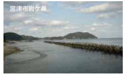
図1-5-4 整備された海岸保全施設
