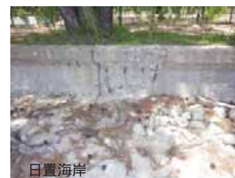
図1-5-6 老朽化した海岸保全施設
