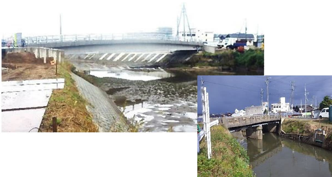
図 8 福田川の改修状況
