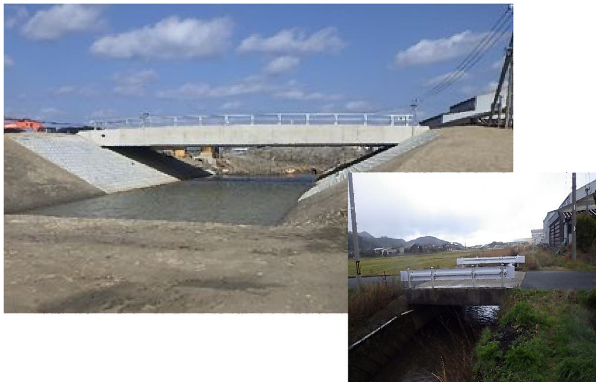
図 9 新庄川の改修状況
