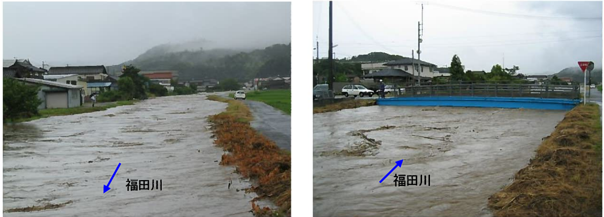
福田川出水状況 (平成 20 年 7 月豪雨)
