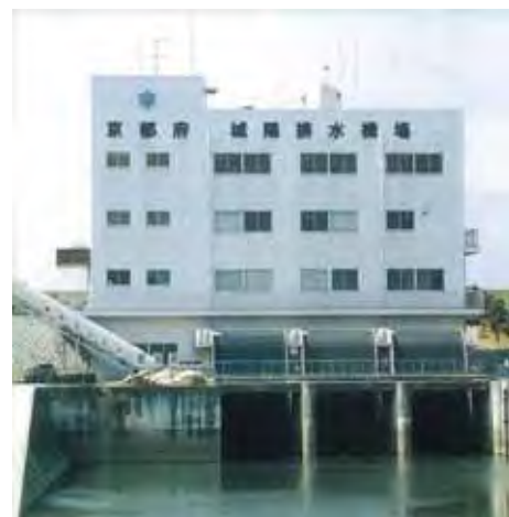
城陽排水機場
