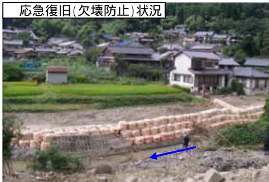
応急復旧(欠壊防止)状況
