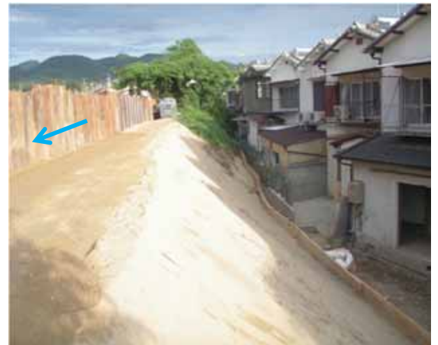
8/31堤内盛土完成
