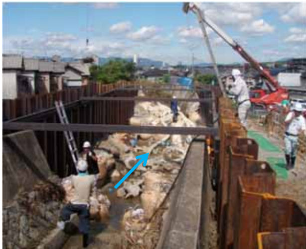
8/22右岸矢板打ち込み完了
