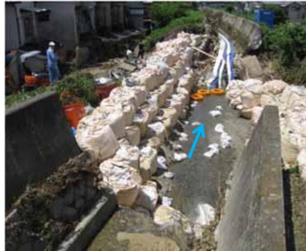
8/16大型土のう積(3段) + ポンプ排水
