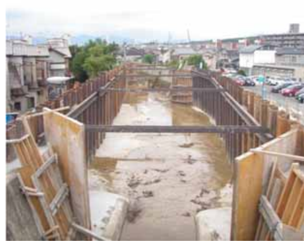
8/27護岸取り付け コンクリート打設
