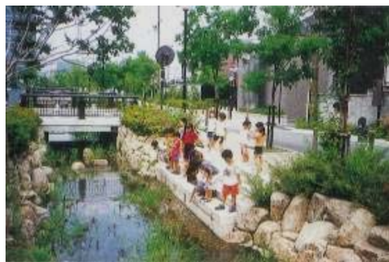
2層式河川上部のせせらぎ整備(七瀬川)
