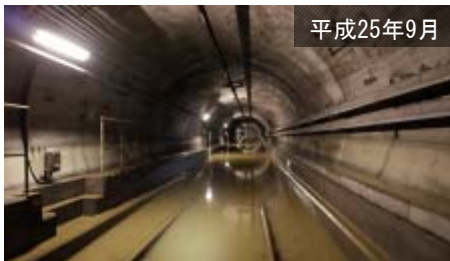
安祥寺川の溢水による 京阪京津線の浸水状況(京都市山科区)
