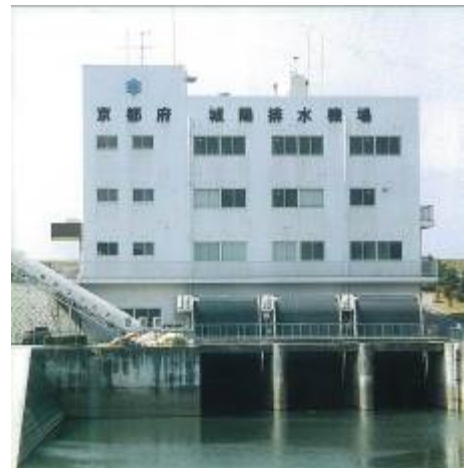
城陽排水機場
