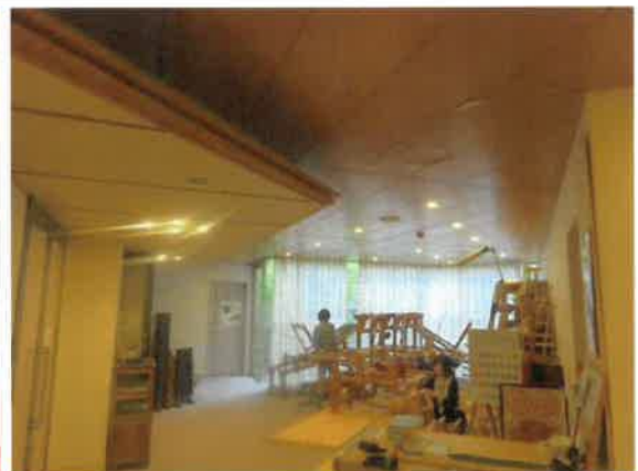
【ホール・着工前】
