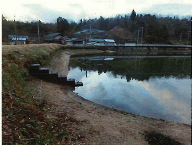
写真3 着工前 堤体・取水施設
