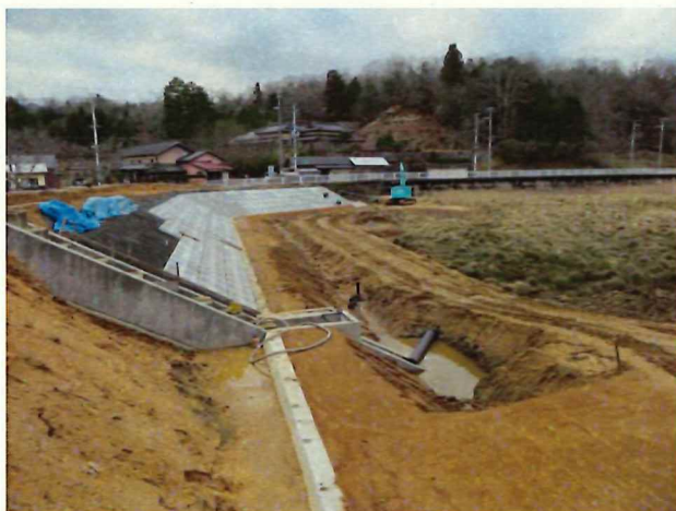
写真5 現況 堤体・取水施設
