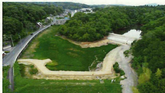
写真2 着工前 下すべ内池(ドローン写真)
