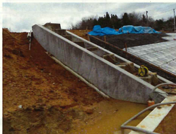
写真6 現況 取水施設
