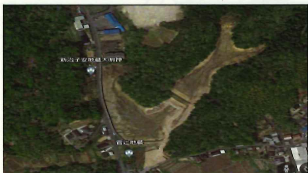
写真1 着工前 下すべ内池(航空写真)
