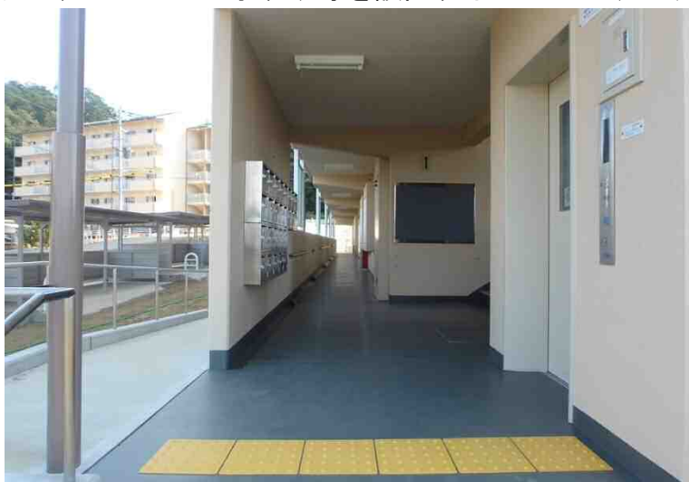
エレベーターホール（建替え後）
