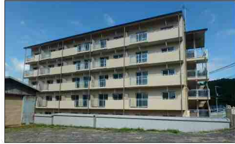
第2号棟 鉄筋コンクリート造 5階建 (平成27年度完成)
