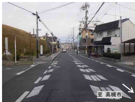
【写真F 片側歩道整備済み区間】
