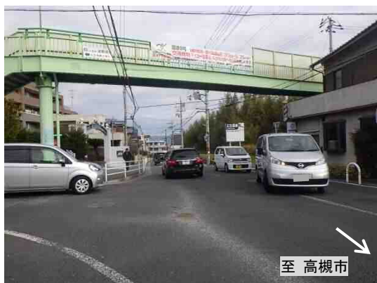
【写真E 起点側交差点の状況】
