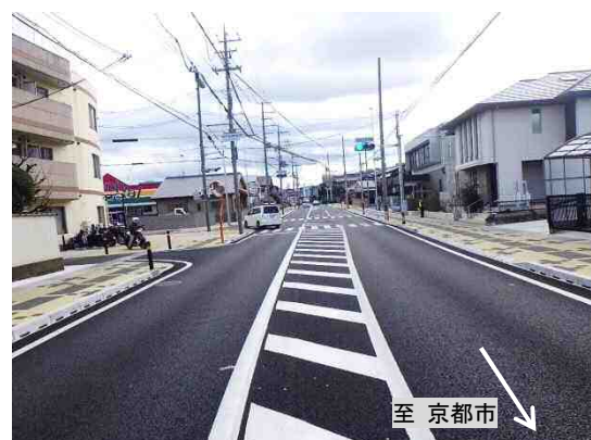
【写真C 改良済み区間】
