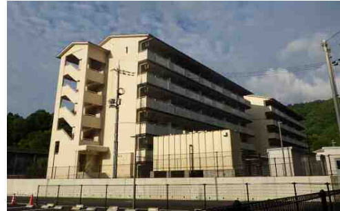
第1号棟 鉄筋コンクリート造 5階建 (平成29年度完成)
