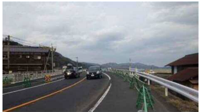
里波見橋改良状況
