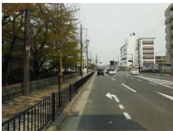
【写真－A 4車線整備済区間】
