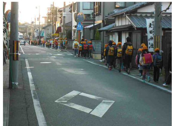
通学路であるが、歩道は幅員が狭く、また一部区間は歩道が未設置となっており、歩行者の安全が確保できていない。
