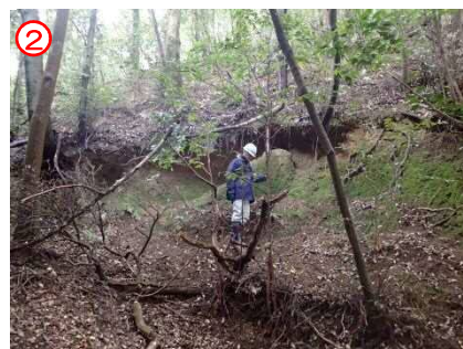
斜面崩壊状況
