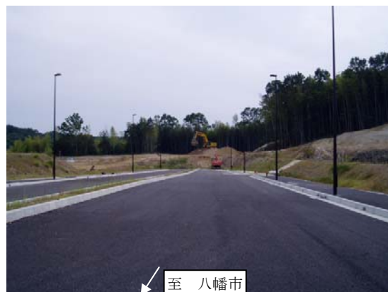
(写真2) 延伸区間（宮津菱田工区） 起点部の状況
