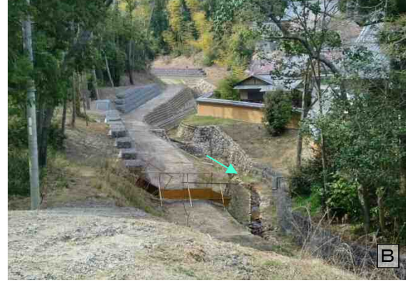
既設溪流保全工
