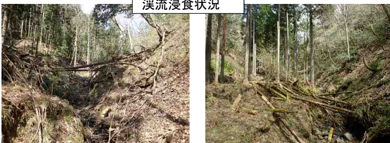
溪流浸食状況
