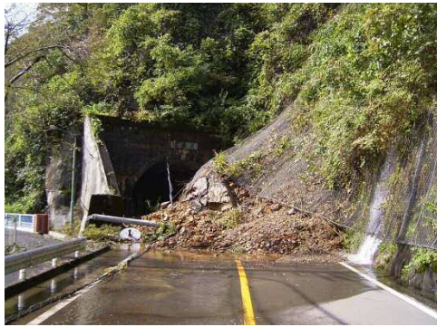
【写真-F トンネル付近の 土砂災害発生状況 (H16.10台風23号)】
