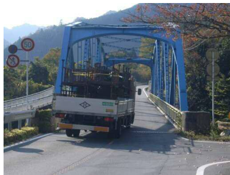
【写真-E 音海橋の通行状況】
