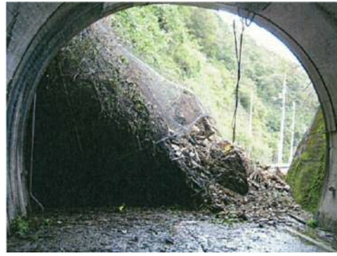
【写真-G トンネル付近の 土砂災害発生状況 (H16.10台風23号)】
