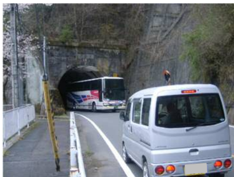
【写真-D トンネルの通行状況】
