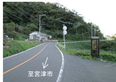
【図-F 現道の状況】
