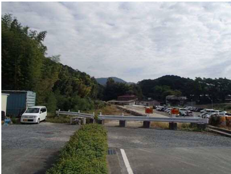
写真③ 西田工区現況（終点側より）
