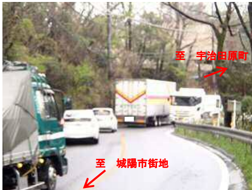
【写真-1 線形不良の状況】
