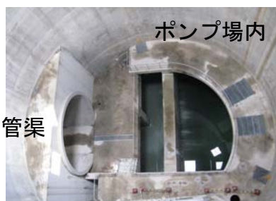
乙訓ポンプ場（上面から）
