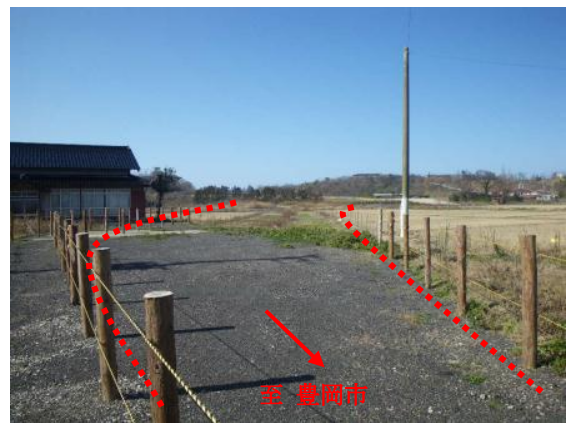
写真② バイパス部と現道拡幅部の接続区間
