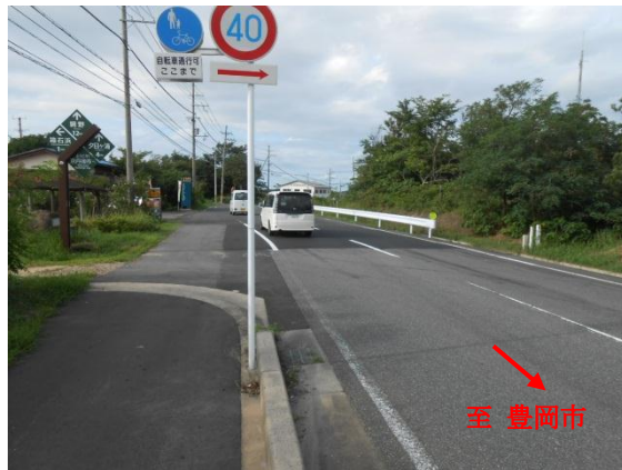
写真① 現道拡幅部【供用済み】
