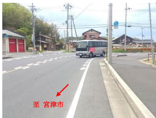
写真③ 起点部の直角カーブ
