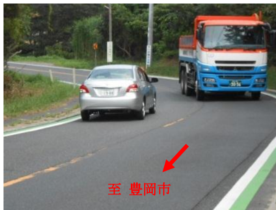
写真③：線形が悪い箇所
