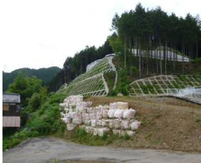
写真② 切土部
