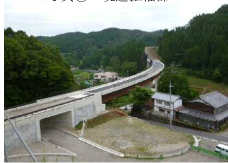
写真③ 奥山田2号橋
