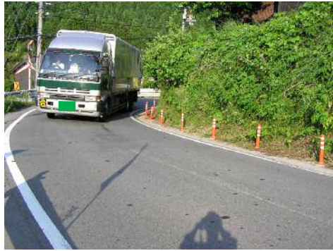
写真① 線形が悪い道
