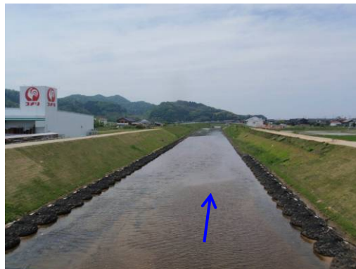
図 9 福田川の改修状況
