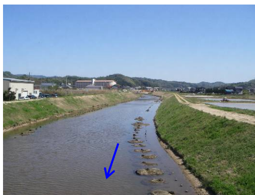
実施後（野島橋から上流側）
