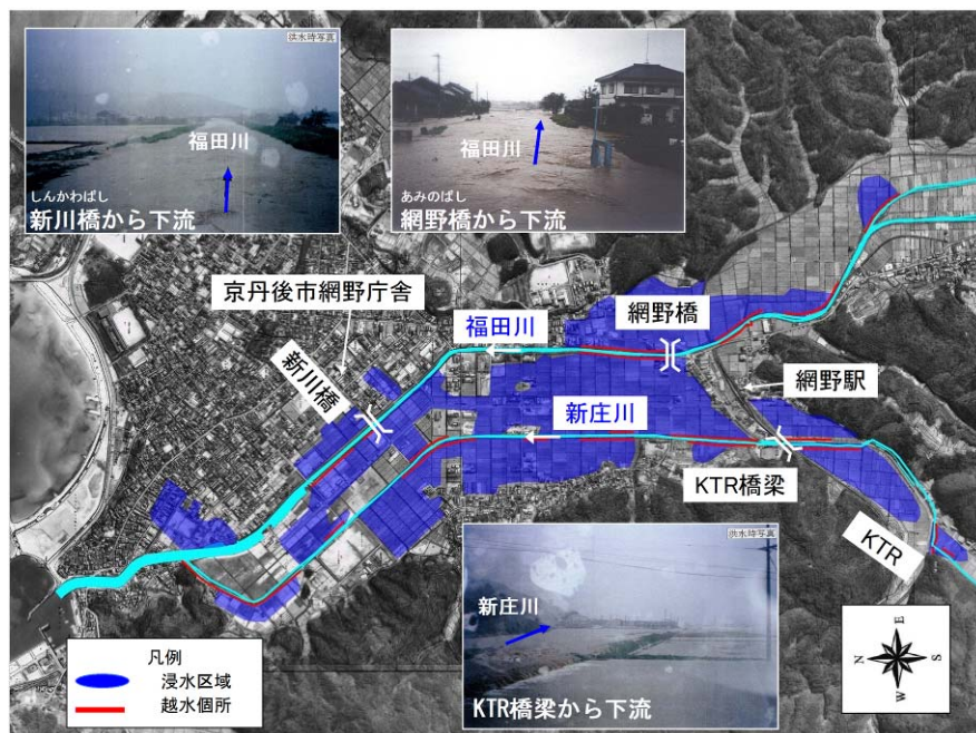
図 5 浸水被害状況（平成 10 年 9 月台風 7 号）
