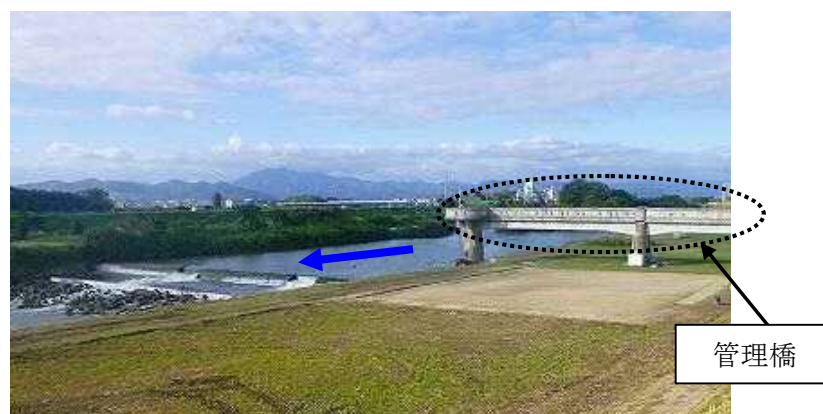
写真 4.1.1 龍門堰の状況(平成26年)
