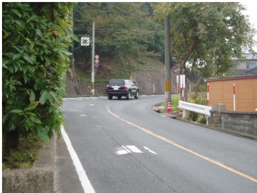
写真① 線形が悪い道
