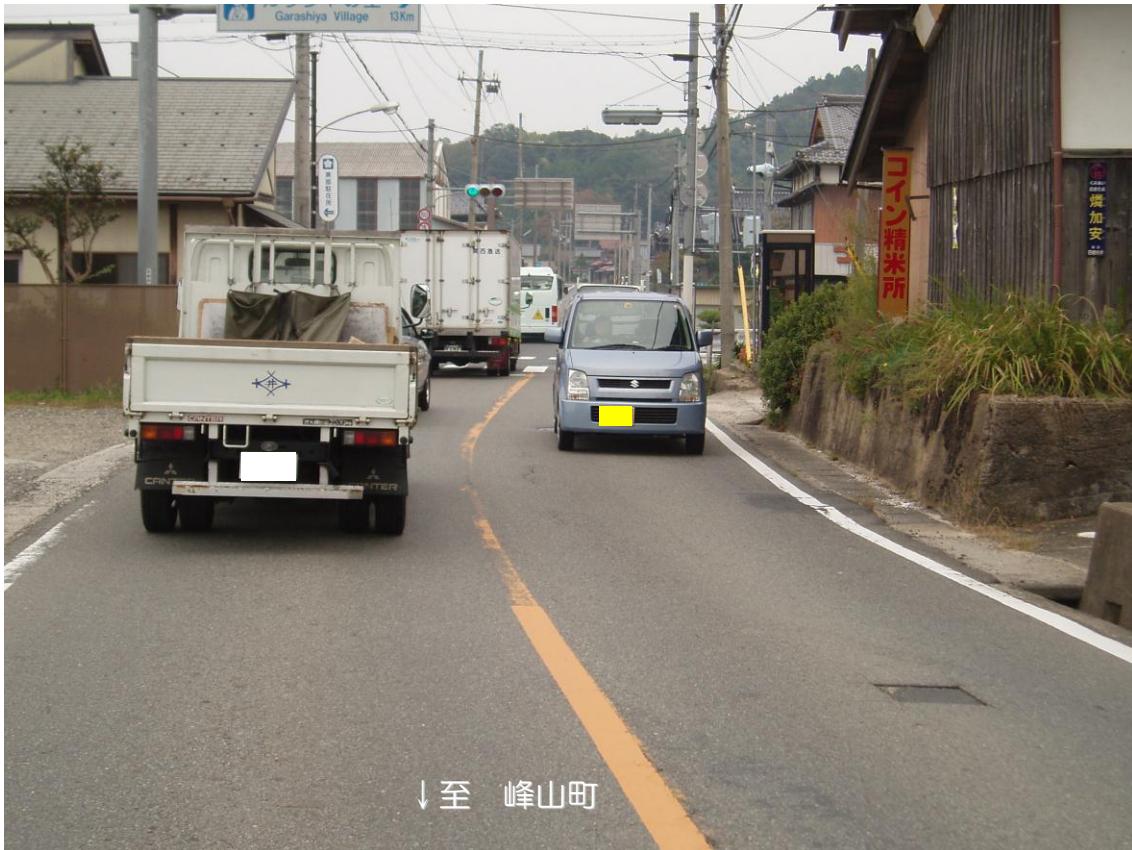
現道の状況（京丹後市弥栄町黒部）
