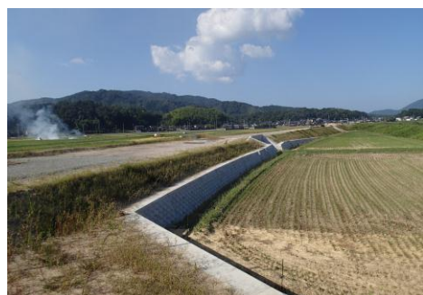
進ちょく状況
