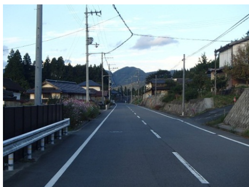
進捗状況 (質美下村工区)
