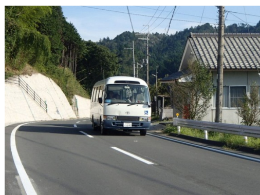
進捗状況 (質美和田工区)
