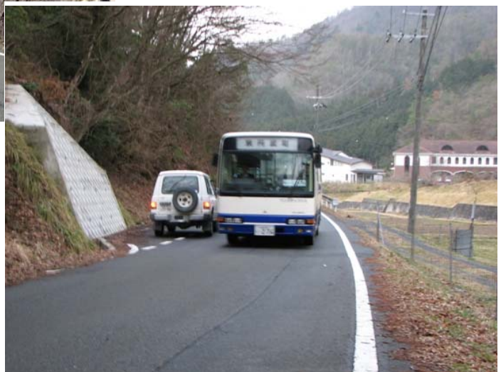
1.5車線改良区間の待避所設置状況 （質美行仏工区 ぎょうぶつ ）
