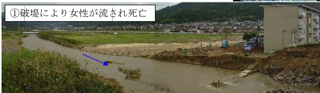
図 6 浸水被害状況 (平成 16 年 10 月台風 23 号)
