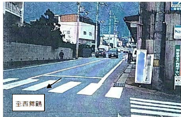
写真2 整備前の状況
