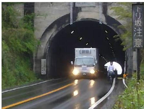
写真14 歩道が無い状況
