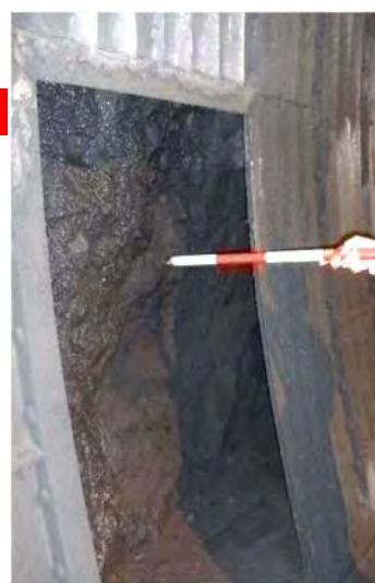
【写真-2 トンネル側面の状況(接写)】
