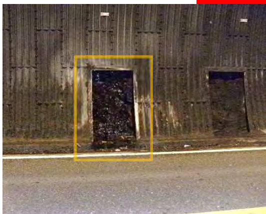
【写真-1 トンネル側面の状況】
