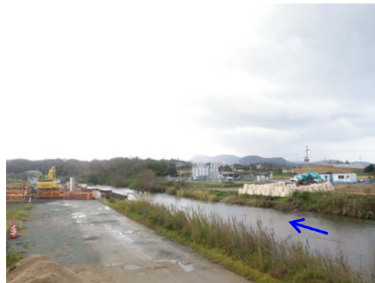
実施中（市道橋ノ坪橋）
