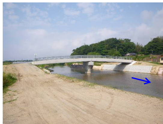
実施後（市道鹿野橋）
