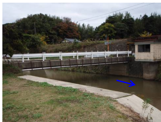
実施前（市道鹿野橋）
