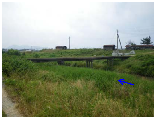
実施前（市道橋ノ坪橋）
