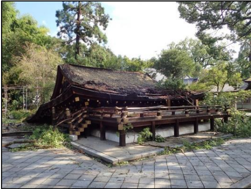
↑平野神社拝殿倒壊（府指定建造物）
