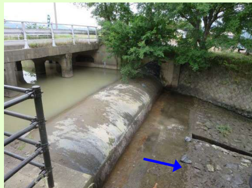
ラバーダムの立ち上げ後
