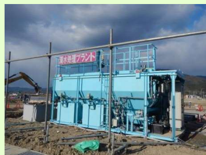
工事で発生した濁水を 適切に処理
