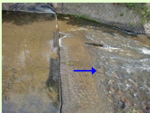
ラバーダム倒伏状態
