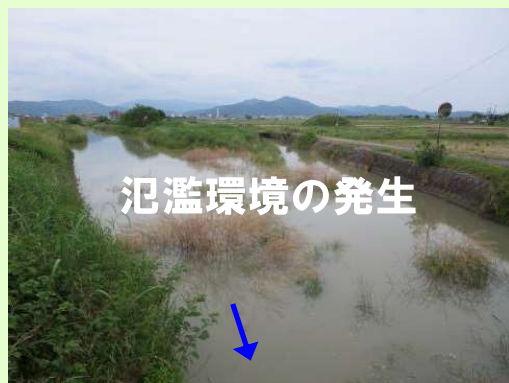
ラバーダム立ち上げによる上流の水位上昇
