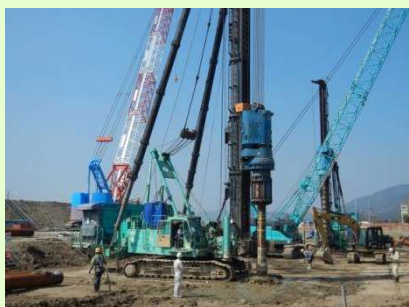
地下水への影響を抑えた 基礎杭工法を採用
