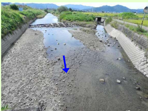
ラバーダム倒伏状態の上流河川
