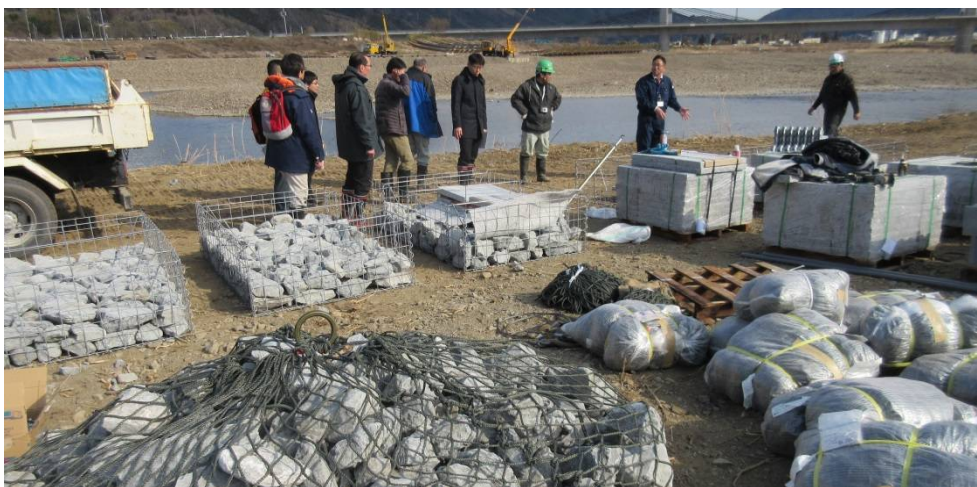
写真 3-2-1 H30. 2. 22 工事指導状況
