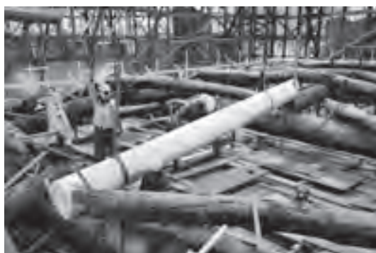
文化財建造物修理現場（本隆寺本堂）
