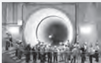
いろは呑龍トンネルポンプ場
