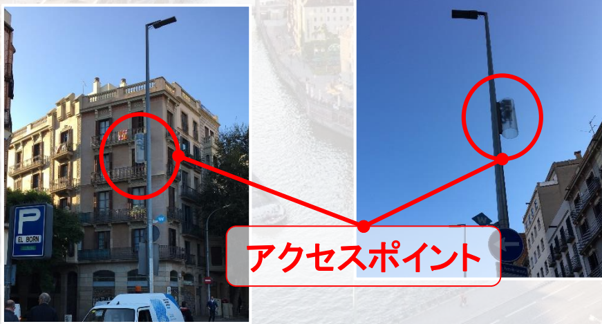
City Wi-Fi / スマート ライティング
