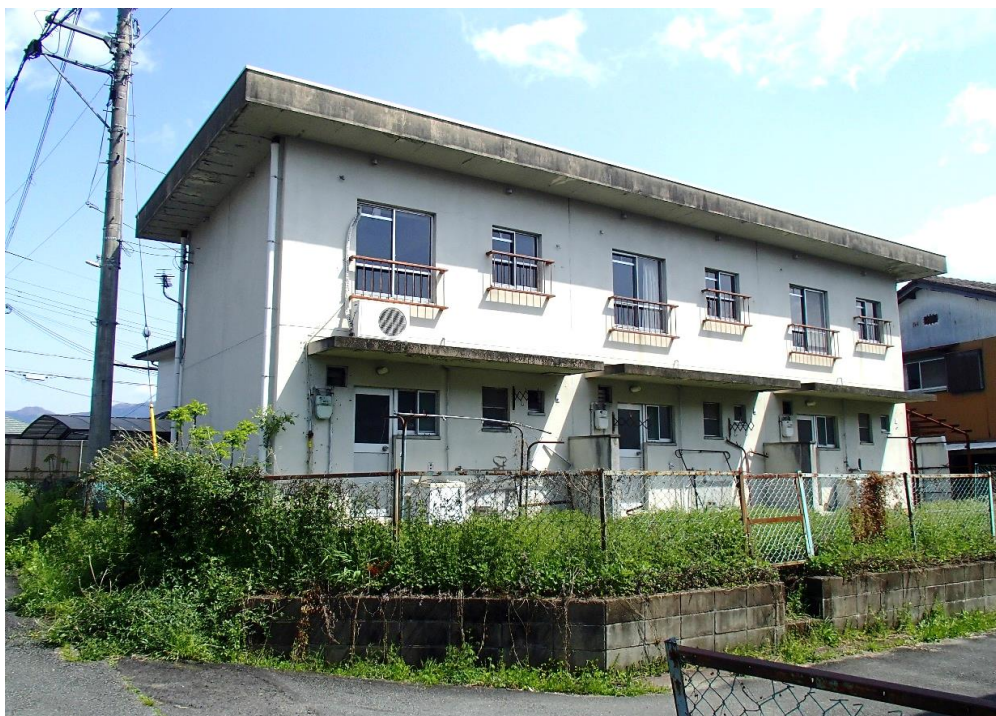
附属建物1・共同住宅
