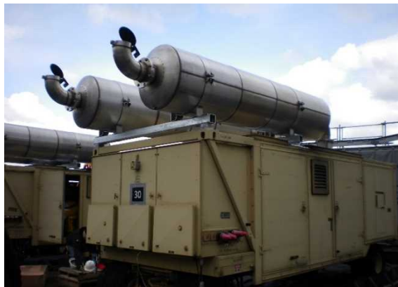
発電機へのマフラー設置
