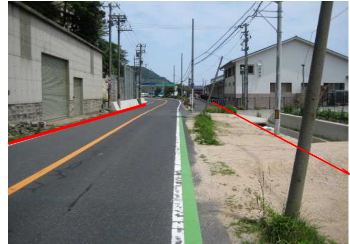
国道482号線(大山工区)
