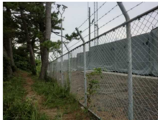
防音パネル(九品寺側境界付近)の設置
