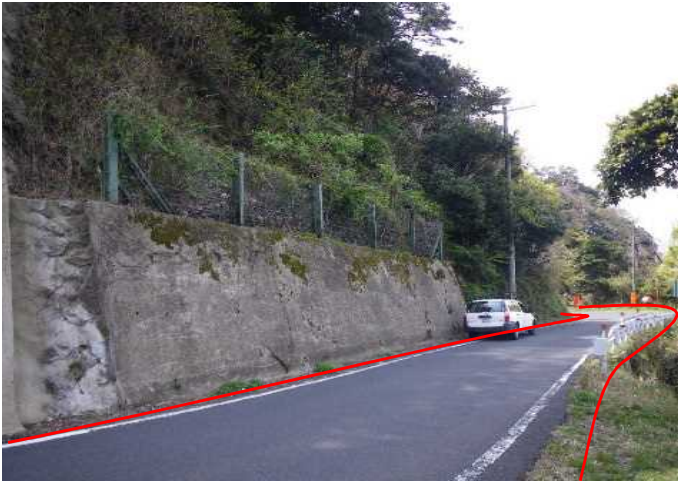
国道178号線(袖志工区)
