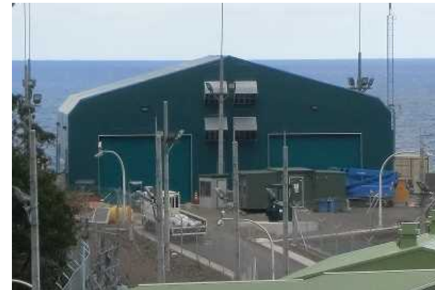
レーダーテントの騒音対策工事の実施
