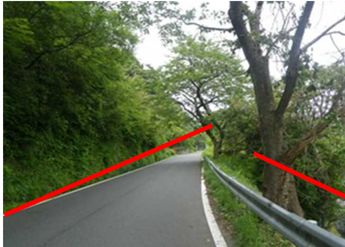
国道178号線(蒲入工区)
