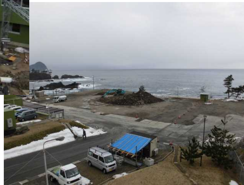
平成30年2月19日 旧庁舎解体跡地の整地状況
